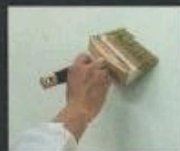
Mano di fondo con Smartcoat 0,1 mm Ground coat with Smartcoat 0,1 mm
