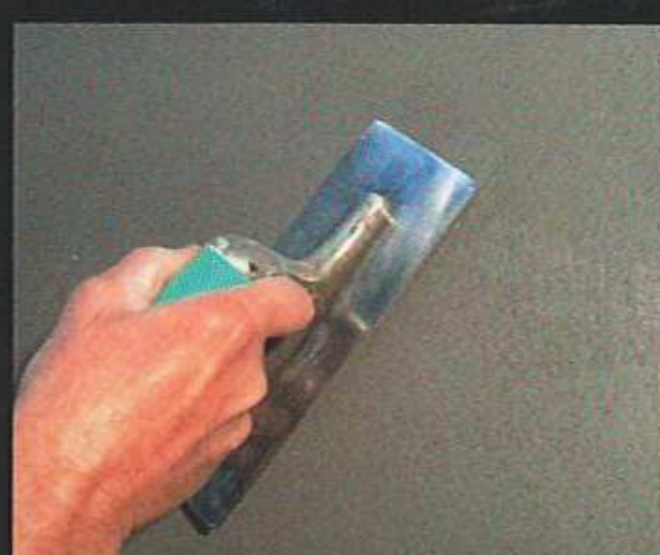
Applicare strato finale di Rasato Antico, Bizantino o Coccio Fiorentino lamando la superficie con con frattone d'acciaio. Apply final layer of Rasato Antico, Bizantino or Coccio Fiorentino, blading (trowel at a 30° angle) the surface by stainless steel trowel.
