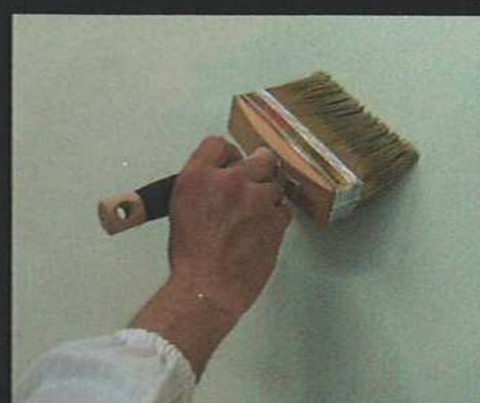
Mano di fondo con Smartcoat grana 0,1 mm Ground coat with Smartcoat grain 0,1 mm
