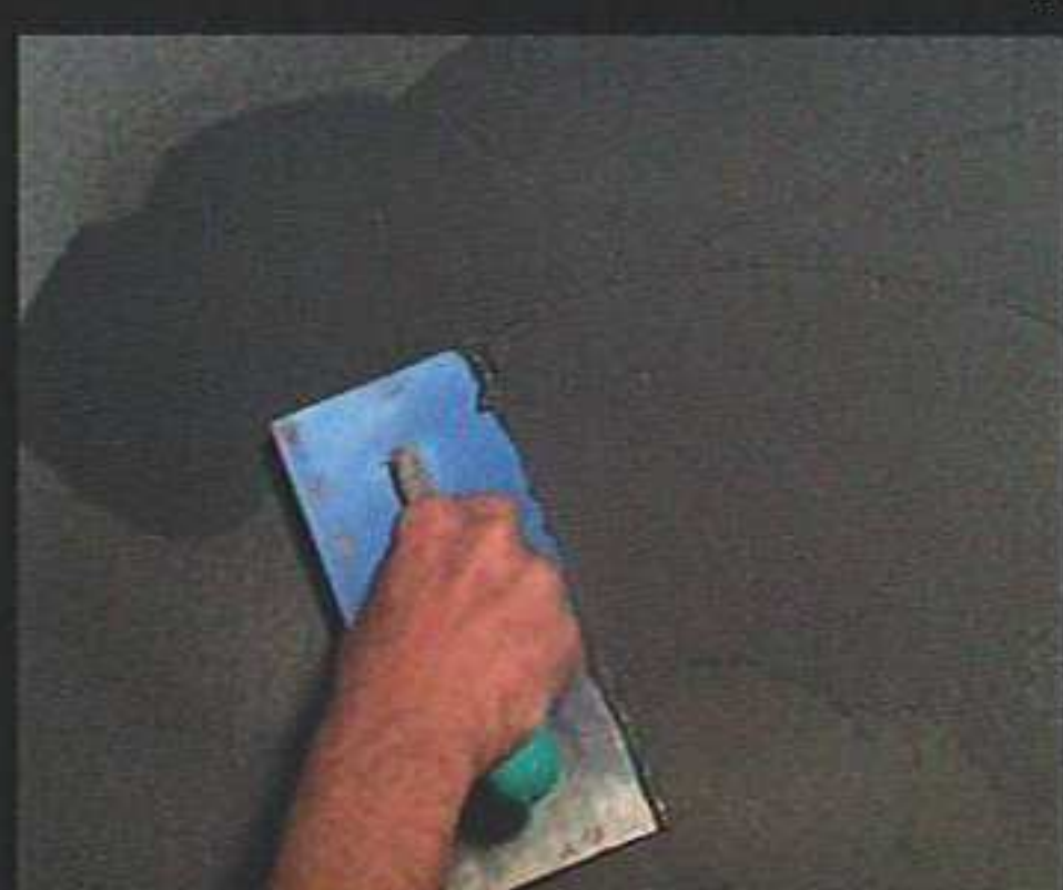
Applicare 1° strato di Rasato Antico, Bizantino o Coccio Fiorentino con frattone d'acciaio. Apply 1st layer of di Rasato Antico, Bizantino or Coccio Fiorentino by stainless steel trowel.
