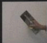
Rasatura con Plastik Top A leveling with Plastik Top A
