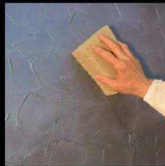
3- RIFLESSI DI LUNA con spugna su Rasato di Calce Fine "strutturato" RIFLESSI DI LUNA with glove on textured Rasato di Calce Fine sublayer
