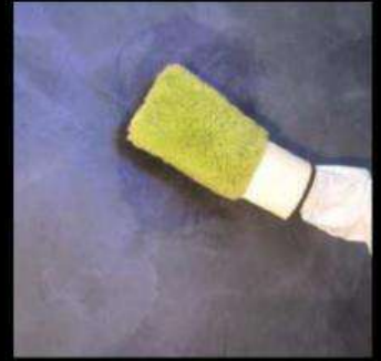
4- RIFLESSI DI LUNA con guanto su Marmo di Venezia RIFLESSI DI LUNA with glove on Marmo Di Venezia sublayer
