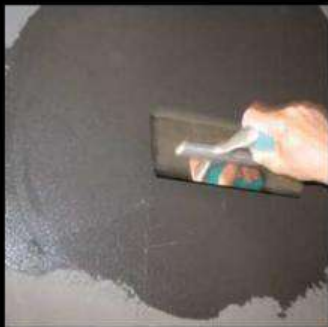
1- Rasato di Calce Fine - 1° mano Rasato di Calce Fine - 1st coat
