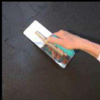
2- Rasato di Calce Fine - 2° mano strutturato a colpi di spatola Rasato di Calce Fine - 2nd coat strutturato by spatula's strokes
