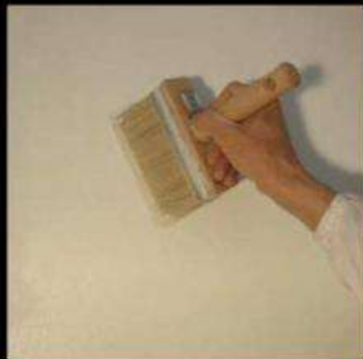
2- Applicazione SABBIA a pennello (2 mani) Application of SABBIA with brush (2 coats)
