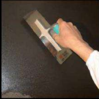
1- Rasato di Calce Fine (2 mani) Rasato di Calce Fine (2 coats)
