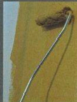
1 a mano Veli d'Oriente (a rullo) 1 st coat Veli d'Oriente (by roller)
