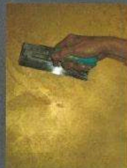
3 a mano Veli d'Oriente (rasato e poi liscio) 3 rd coat Veli d'Oriente (smoothed and bladed)
