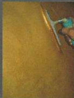
2 a mano Veli d'Oriente (a spatola) 2 nd coat Veli d'Oriente (by spatula)
